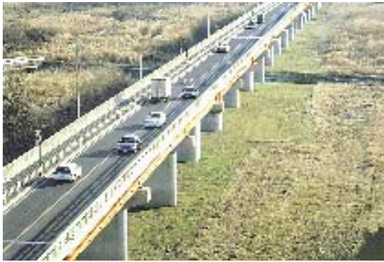
耐震補強を完了している新大利根橋
