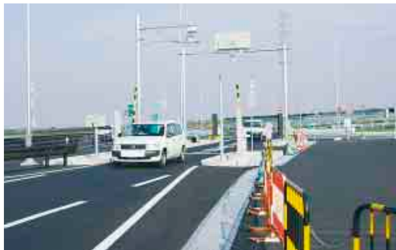
水戸北スマートインターチェンジ
