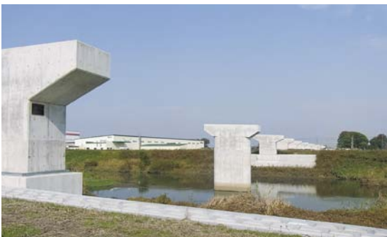
建設が進む圏央道(五霞町幸主地区)
