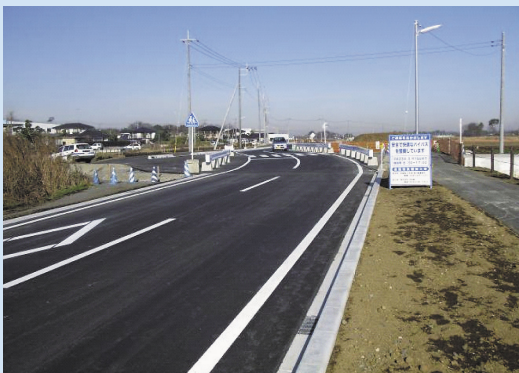
整備が進む関連道路(県道尾崎境線)
