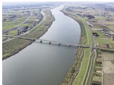
アクセス道路の整備が進む若草大橋
