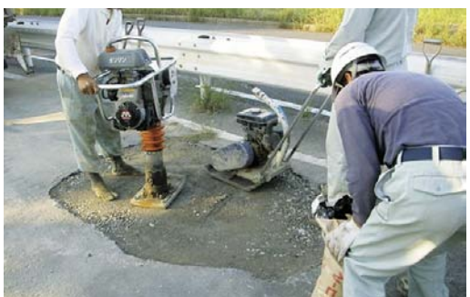
道路の補修工事の様子
