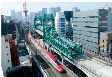
常磐線の東京駅乗り入れ工事の様子
