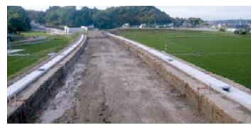
整備が進む県道里根神岡上線バイパス(北茨城市)
