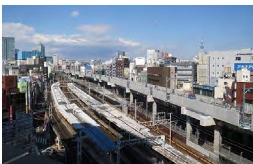
上野東京ラインの線路(右側の高架橋)
