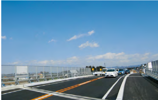
震災による架替工事が完了した静踏線橋(那珂市)
