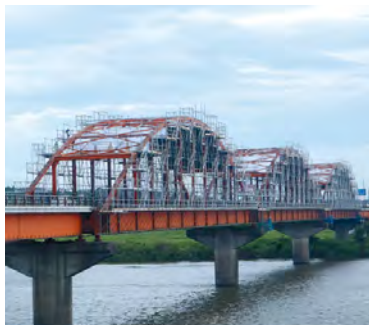
橋りょう(長豊橋)の修繕工事の状況
