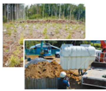
豊かな森林と美しい湖沼のために(高度処理型浄化槽の設置、再造林の様子)
