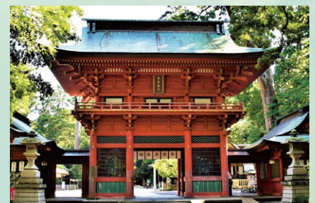
鹿島神宮: 鹿嶋市宮中2306-1 坂戸神社: 鹿嶋市山之上228 沼尾神社: 鹿嶋市沼尾1298
