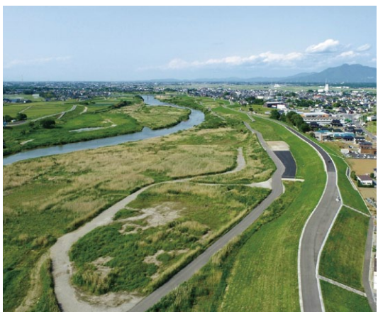
▲鬼怒川決壊箇所の堤防整備(常総市上三坂)
