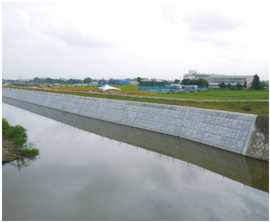
▲八間堀川決壊箇所の堤防整備(常総市平町)
