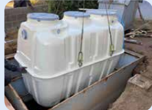
▲高度処理型浄化槽の設置
