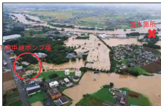
鬼怒川溢水 下妻ポンプ場 周辺写真
