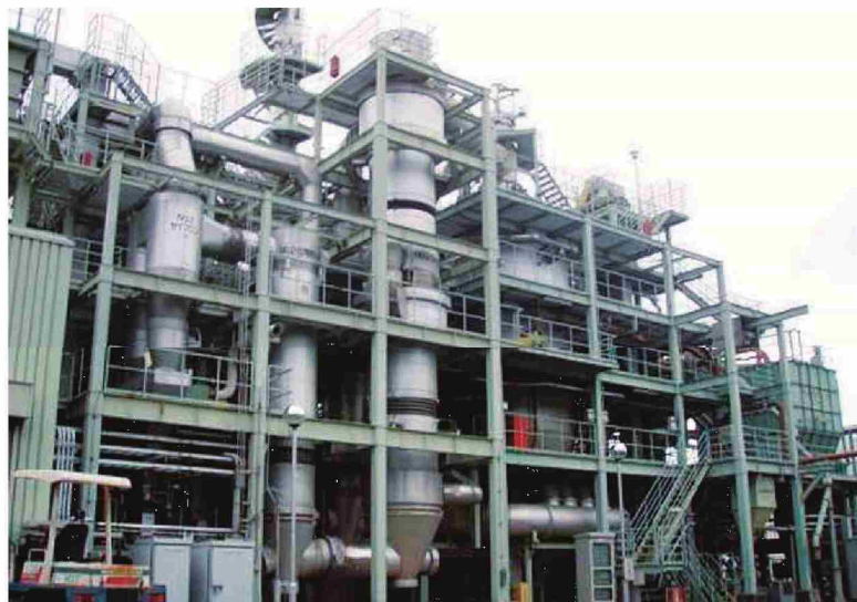
広域汚泥 1号焼却炉
