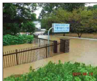
下妻ポンプ場入口浸水状況
