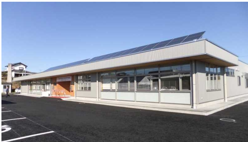
土木事務所 (外観)
