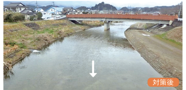
堆積土砂の撤去により、本来の流下能力を確保：花園川（北茨城市）
