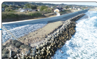
角折海岸 高潮対策事業 (鹿嶋市)
