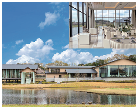
偕楽園(水戸市) ＜Park-PFIにより整備したパークレストラン＞
