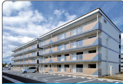
桜川西アパート(水戸市)
