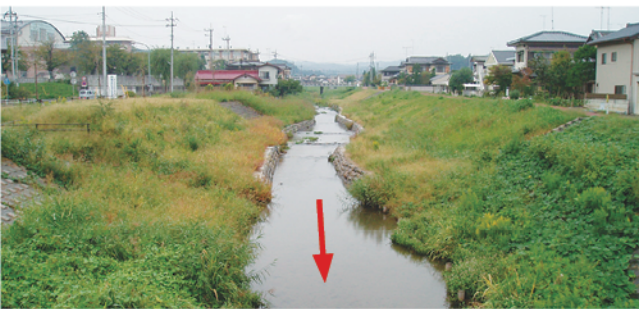
緩傾斜護岸や瀬、淵を設けるなど、多自然川づくりがなされている源氏川（常陸太田市）
