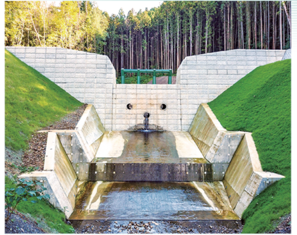
砂防事業（堰堤工） 大栗沢（常陸大宮市）
