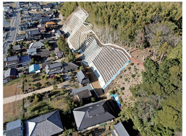
急傾斜地崩壊対策事業 井才天2（小美玉市）
