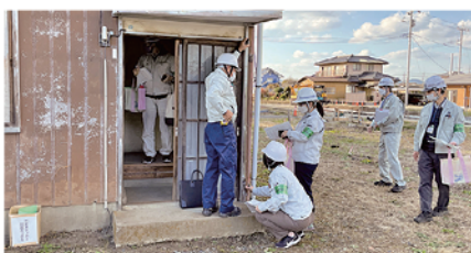
被災モデル建築物による判定模擬訓練 （R4.11 城里町）
