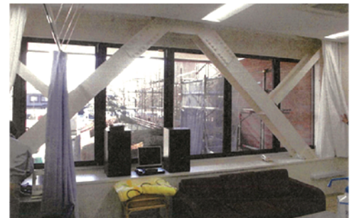
大規模な建築物の耐震改修（ブレース設置）事例
