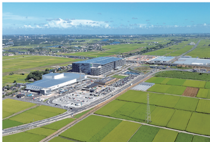
常総市常総インターチェンジ土地区画整理事業（常総市）
