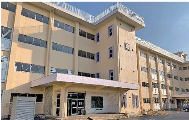
水戸商業高校管理教室棟長寿命化改修工事
