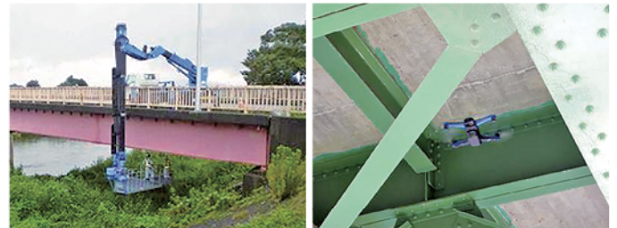
橋梁点検車による橋梁点検状況
