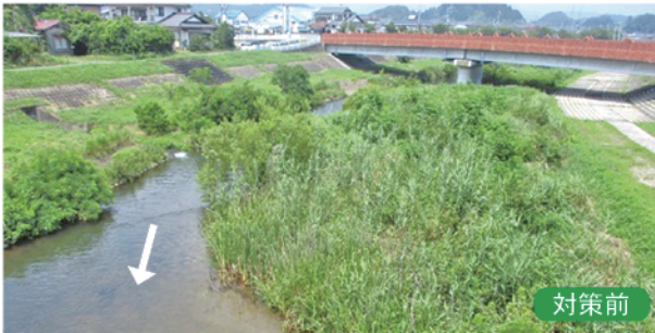
堆積土砂の撤去により、本来の流下能力を確保：花園川（北茨城市）
