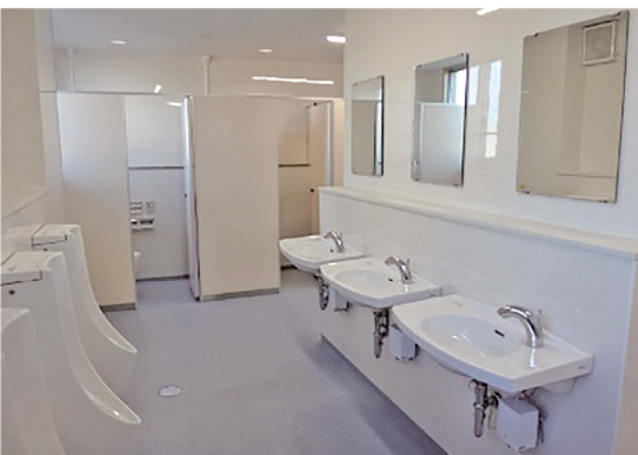
多賀高校本館トイレ改修工事
