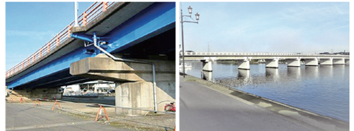
県道北茨城大子線 磯原跨線橋 (北茨城市)
