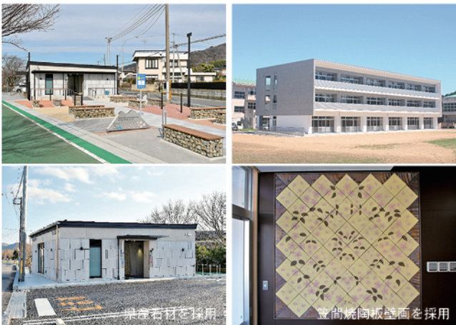
左側：りんりんロード筑波休憩所改築工事 右側：美浦特別支援学校普通教室棟増築工事
