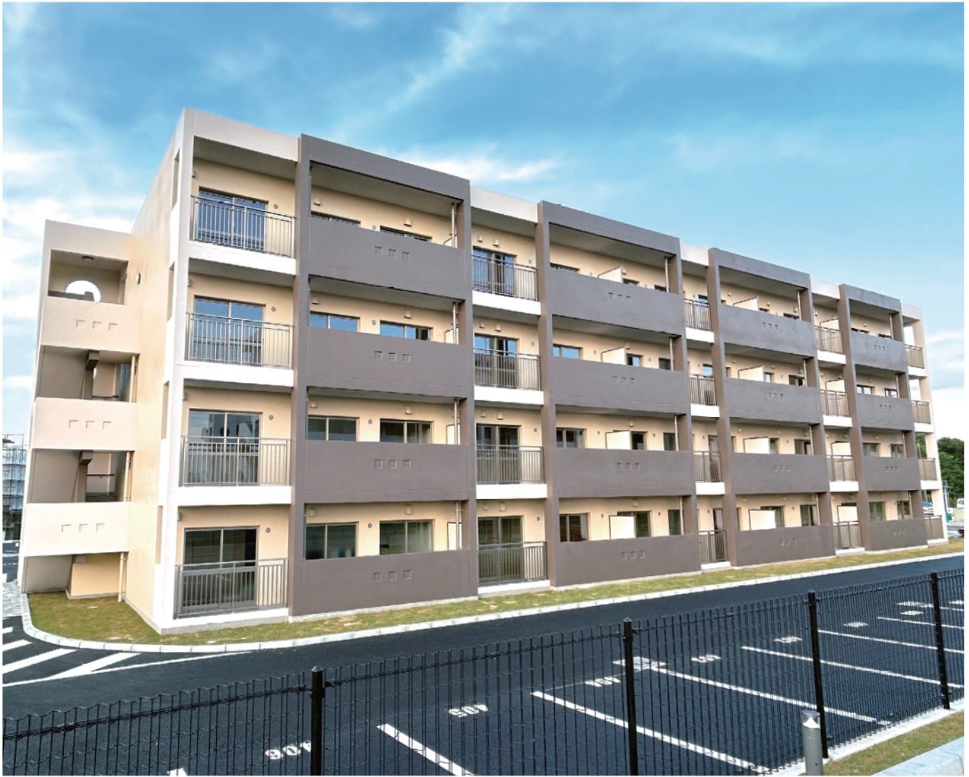
都和アパート17号棟（土浦市）：老朽団地の建替事業
