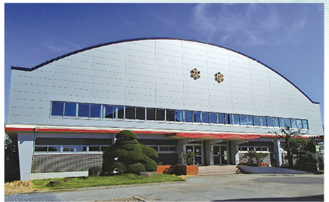
下館第一高校屋内運動場長寿命化改修工事
