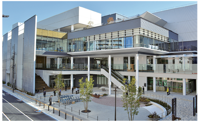
駅前の賑わいを再生したアルカス（図書館）（土浦市）
