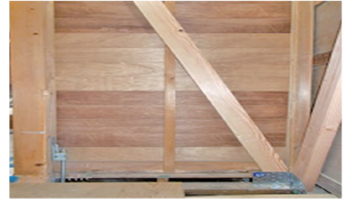
木造住宅の耐震改修（筋交い設置）事例
