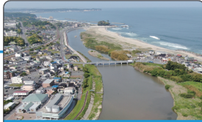
大北川河川改修事業 (北茨城市)
