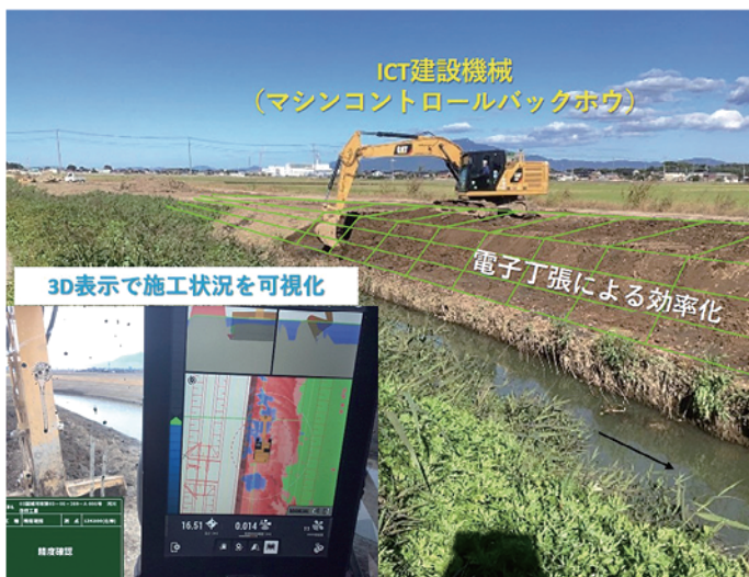
ICT 建機による施工
