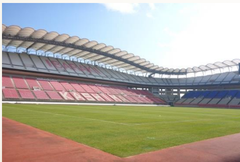
カシマサッカースタジアム修繕工事（鹿嶋市）
