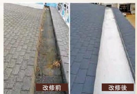
屋根防水修繕工事
