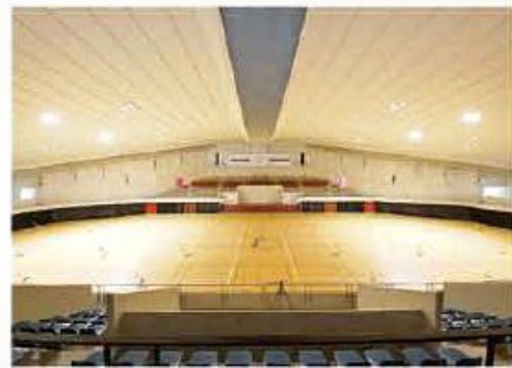
笠松運動公園体育館アリーナ空調改修工事（ひたちなか市）
