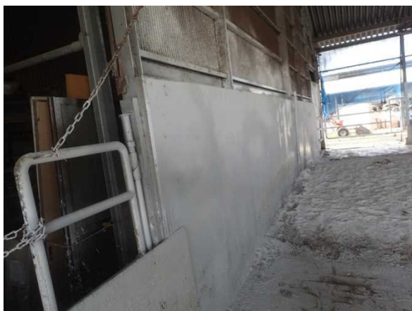
写真 5 牛舎壁面石灰乳塗布
