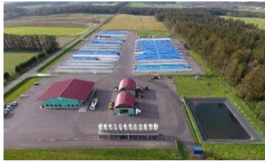
TMRセンター：TMR（混合飼料）を製造し、酪農家へ配送する施設
