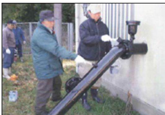
①施設の点検・機能診断
