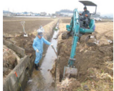
②水路の補修
