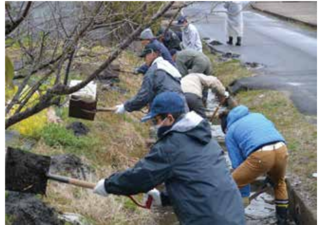
泥浚いの様子
