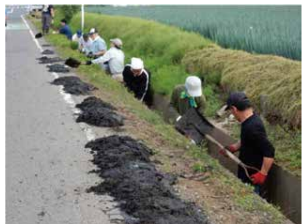
側溝の泥上げ
