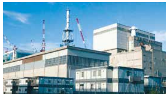
東海発電所外観（2003年9月撮影）
