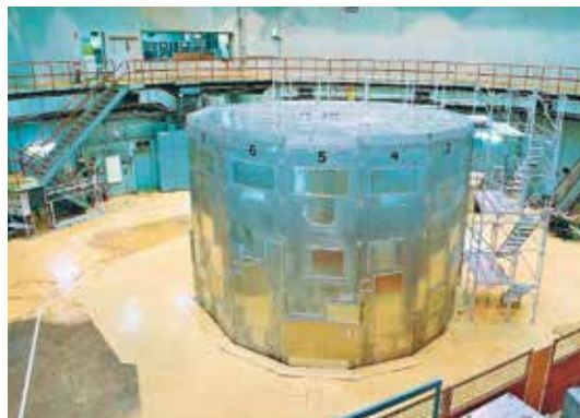
解体中のJRR-2 (原研東海)
