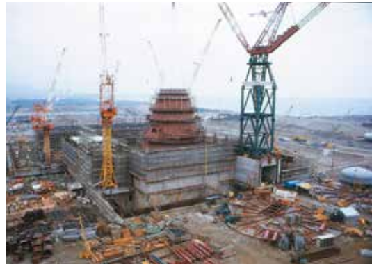
建設中の東海第二発電所（原電）
