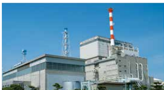
東海発電所外観（2002年7月撮影）
