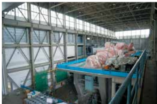
タービン発電機撤去前（2003年3月撮影）
