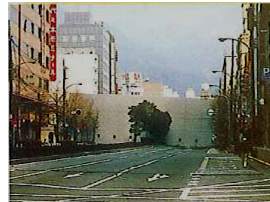
【緊急輸送道路の閉塞】
