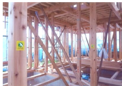
建築中の住宅
