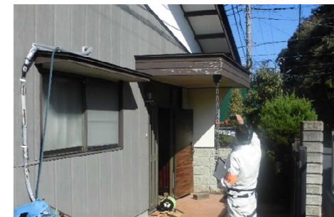
耐震診断士の診断作業の様子
