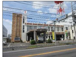
古河警察署現況 (S41年3月築)
