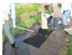
農道の部分補修
