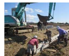
コンクリート水路の布設
