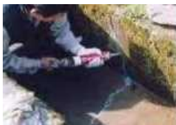
水路のひび割れ補修
