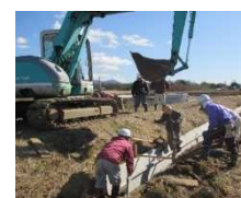
コンクリート水路の布設
