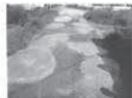
農道の窪みの補修
