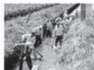
水路の泥上げ
