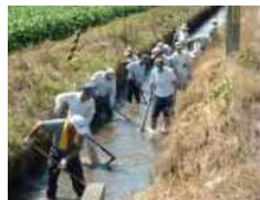
水路の泥上げ
