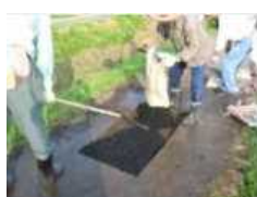
農道の部分補修
